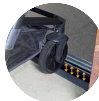
Desnivel entre cabina y el suelo
